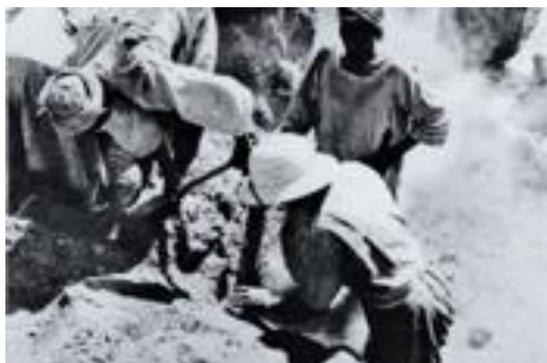
Le chantier des fouilles
