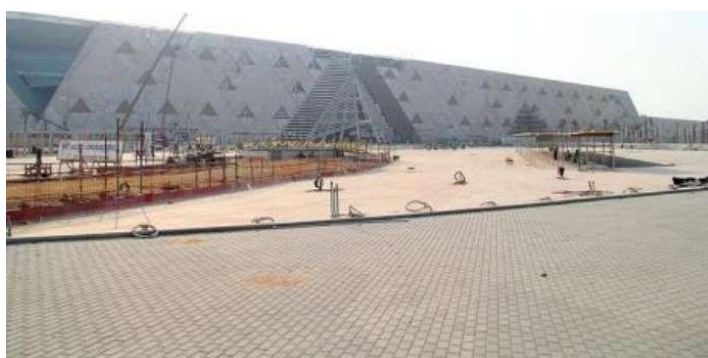
Photo du Chantier 2019
